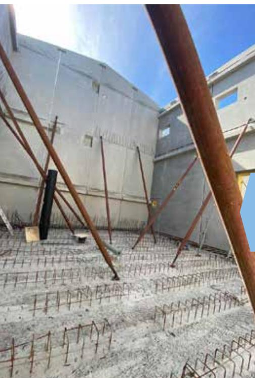
Der Reinwasserbehälter wird rund 1,70 Meter und das Pumpenhaus etwa 2,70 Meter unterhalb der Geländeoberkante gegründet. Da der Baugrund in dieser Tiefe nicht ausreichend tragfähig ist, erfolgte eine erschütterungsfreie Pfahlgründung über 113 Vollverdrängungsbohrpfähle.
